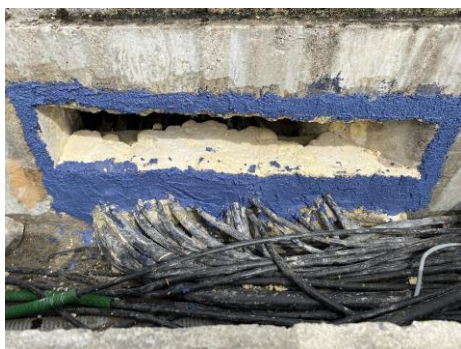
MASTISOL® sur le contour de la trémie
