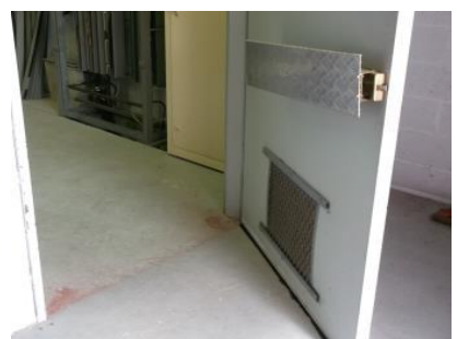
BROSSOL®-Rod fixée au bas des portes
