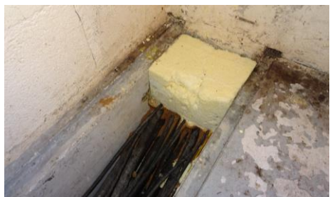
Fourreaux protégés par COVERSOL ®
